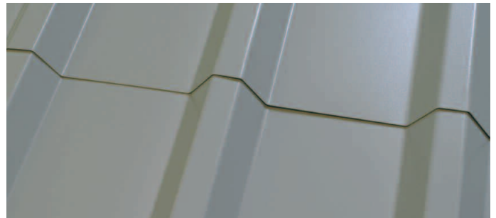
Bord coupé d'une tôle de toiture.
